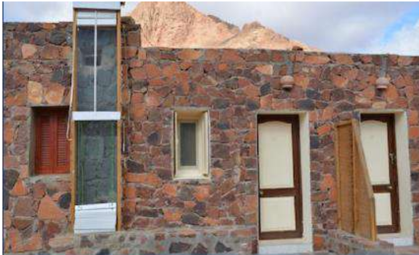
Figure I. 39 : Mur Trombe réalisé par Marwa Dabaieh [78].
